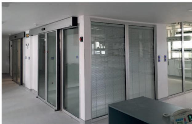
**Figura 2** O vazio dentro das paredes onde correm as portas dificilmente consegue ser limpo e desinfectado.
